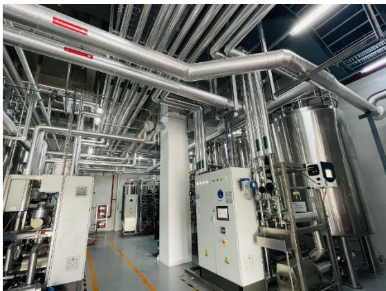
水系统（纯化水、注射用水、纯蒸汽）
